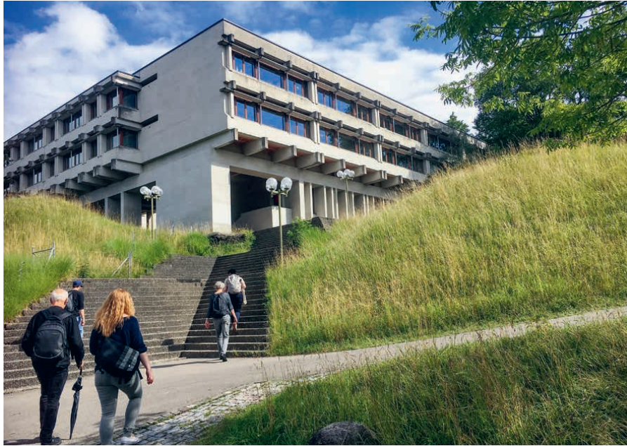
Schulanlage Stettbach, Zürich Centre scolaire Stettbach à Zurich
