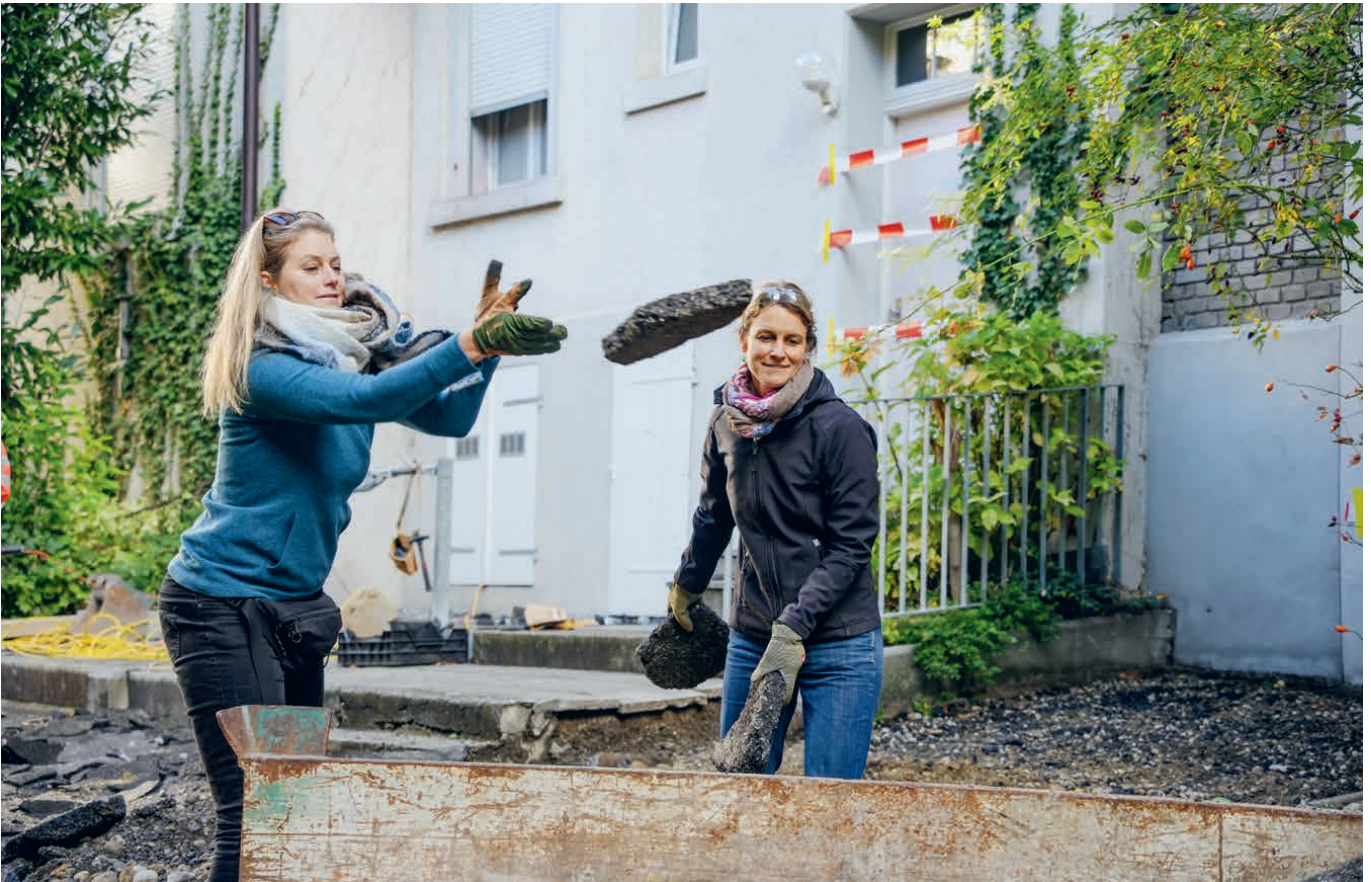
Der aufgebrochene Asphalt wird abtransportiert und fachgerecht entsorgt. Les plaques de goudron sont évacuées et éliminées dans les règles de l'art.
